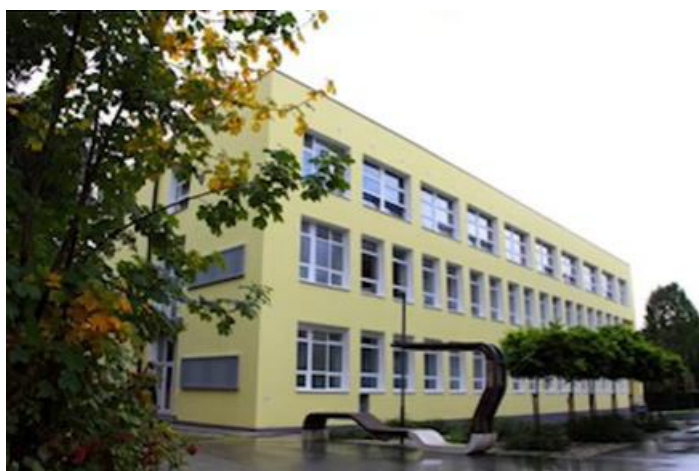
Slika 24: Šolski center Velenje, gimnazija, stavba A [29]
